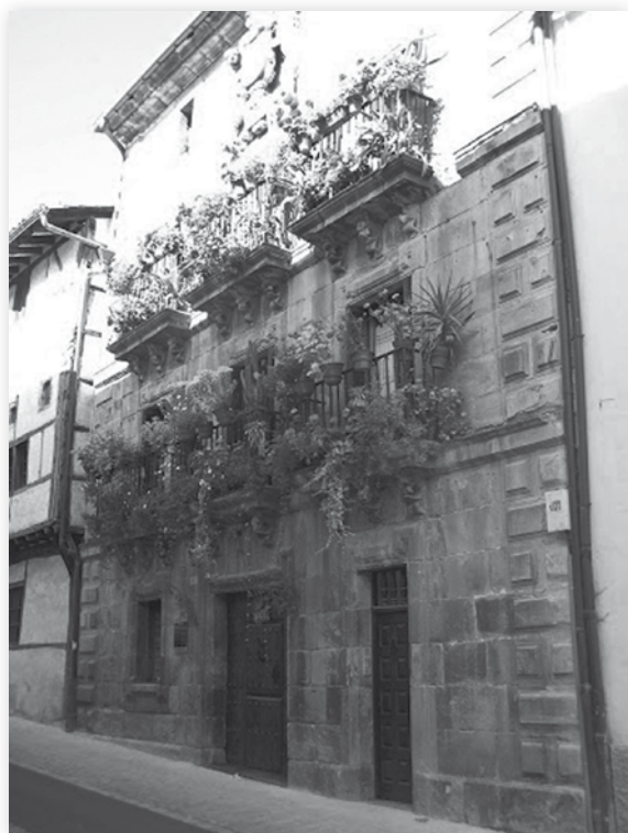
Casa de Alcibar-Jáuregui en Segura.
